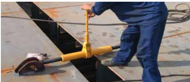
El gato tensor se utilizó para sujetar las secciones de esta plataforma. ▼
